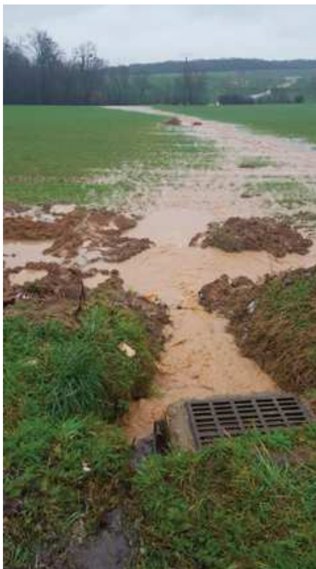
A l'entrée de Montpichet, regard après nettoyage recueillant les eaux venant des champs
