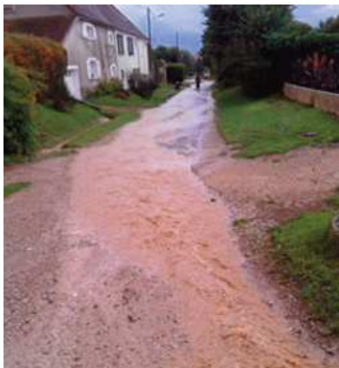
Torrent d'eau s'écoulant des champs vers la rue du Tilleul
