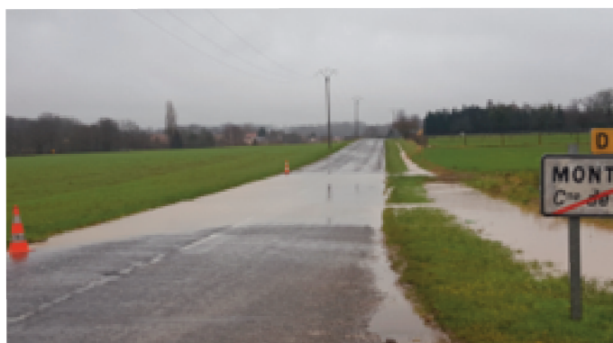
La D33e inondée à la sortie du hameau de Montpichet
